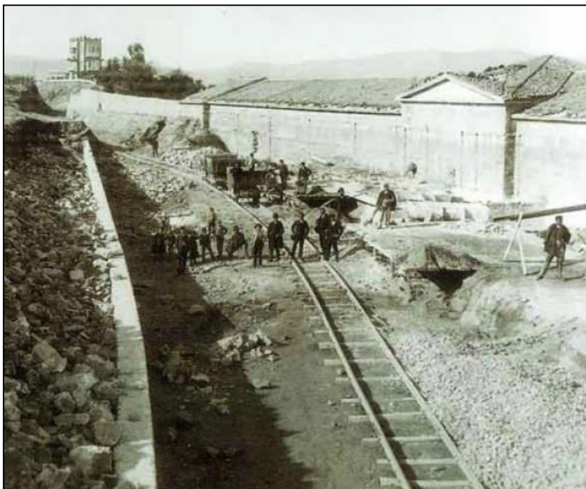
Εικ.3 Στιγμιότυπο από τα έργα κατασκευής του σταθμού του Θεσείου (1868)
